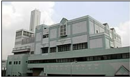
ごみ焼却工場棟
